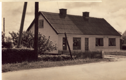
Ålborgvej 573 før tilbygning
